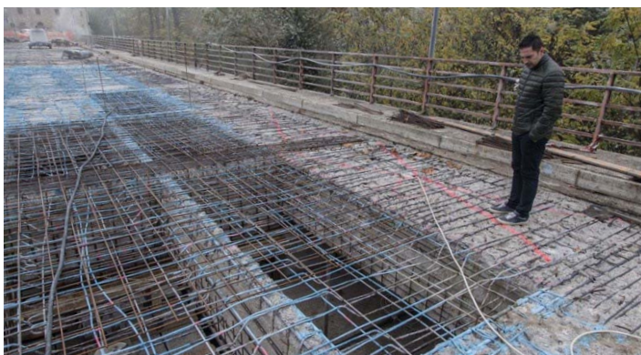
Lavori sul Ponte Conciatori
