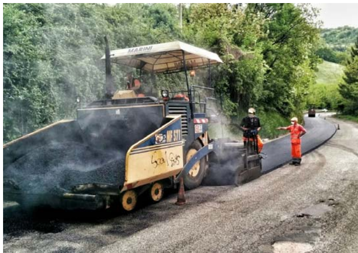
Lavori di bitumatura strade
