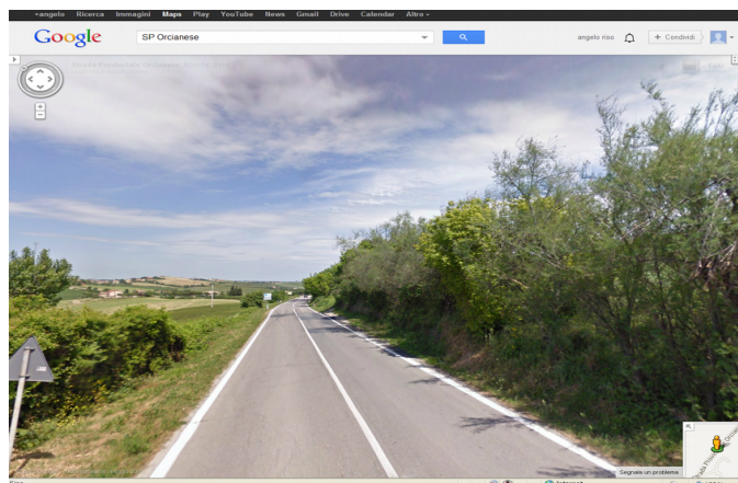
Figura 2 – Sezione tipo della SP 16 (vista della strada nel Comune di Orciano di Pesaro)
