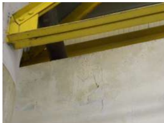
Macchia infiltrazione interna
