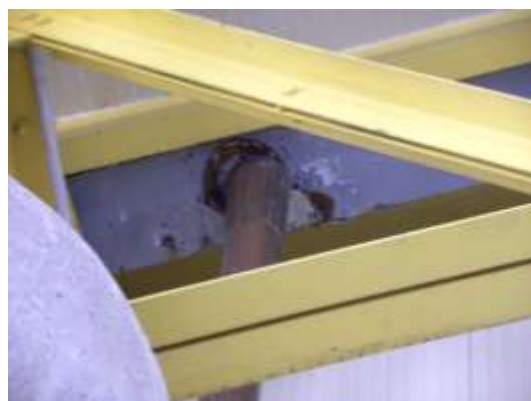
Particolare grondaia SUD con infiltrazione
