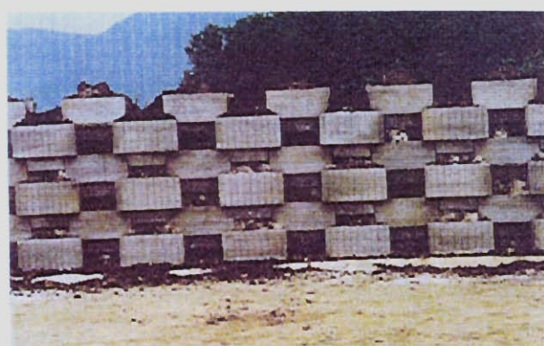
Figura 4: Muro cellulare con funzione antirumore.
