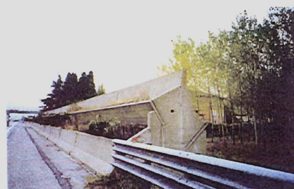
Figura 5: Muro vegetato a struttura composita in elementi prefabbricati.
