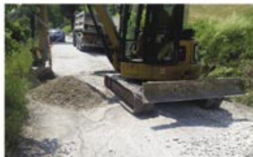
Durante i lavori
