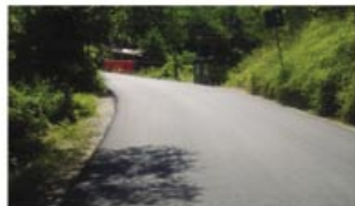
Dopo i lavori
