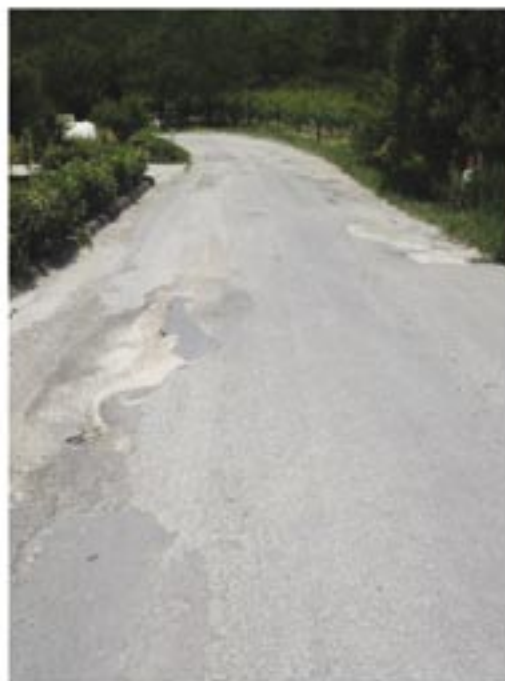
Prima dei lavori
