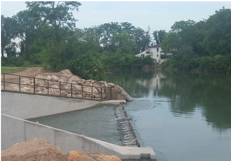
Figura 3 – Esempio di barriera paratronchi sommersa (bocca di presa HPP Asola – Fiume Chiese – MN)
