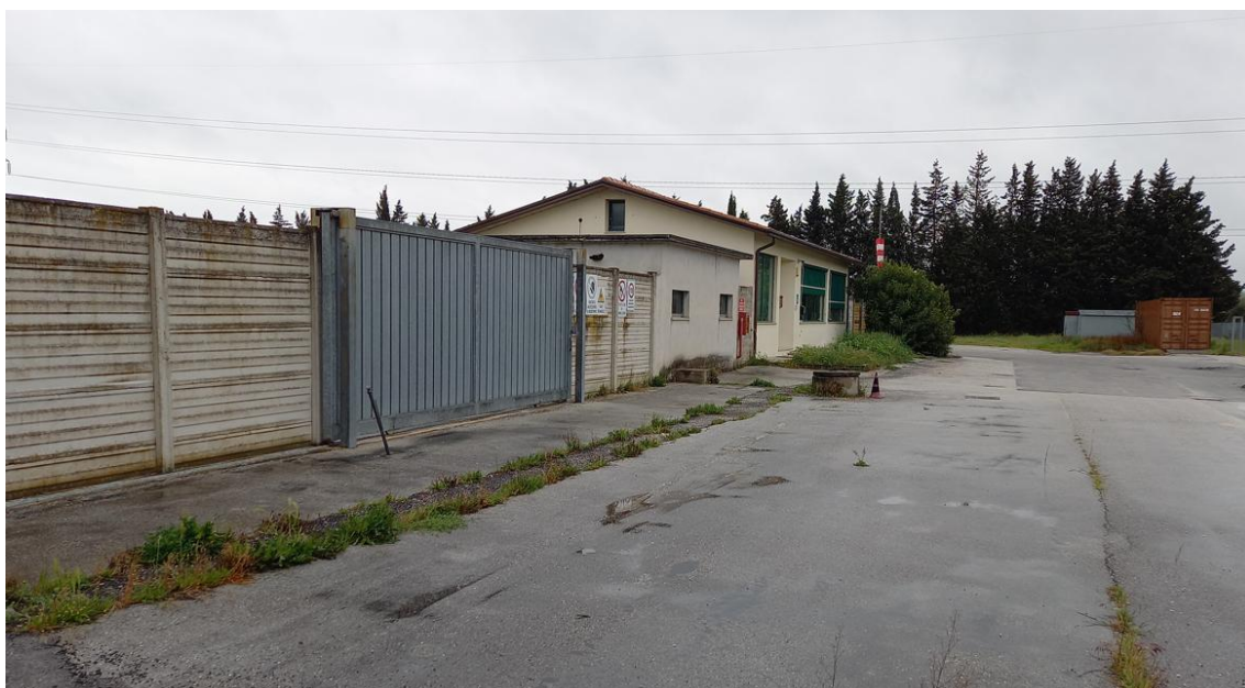
Foto 6 – parcheggio esistente e palazzina uffici dell'impianto in dismissione. Tutte le installazioni e i fabbricati esistenti saranno rimossi provvedendo ad una complessiva bonifica dell'area. Le pavimentazioni in asfalto saranno rimosse e verrà ripristinato il cotico erboso.
