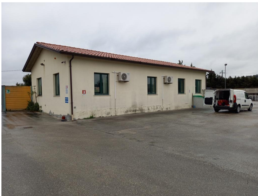
Foto 6 – palazzina uffici/direzionale/servizi. Per essa è prevista una attività di demolizione selettiva con smontaggio di tutte le parti recuperabili e riutilizzabili (impianti, infissi, serramenti, canaline, pluviali, ecc).
