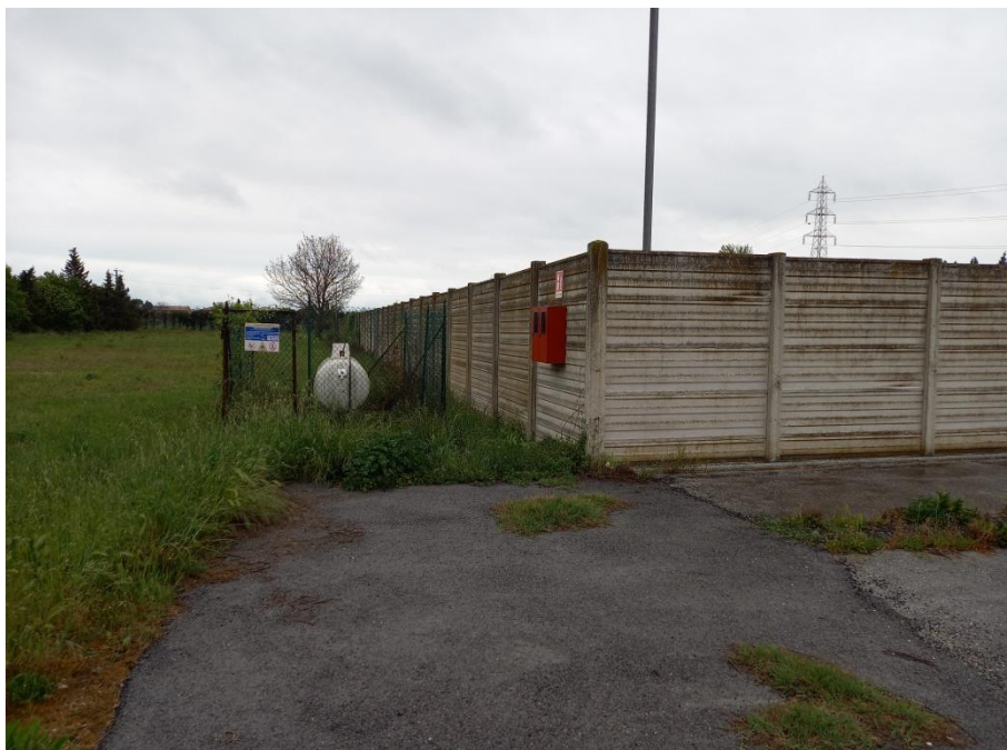
Foto 1 – pannelli in cemento al confine esterno della zona di stoccaggio. I pannelli saranno demoliti e recuperati come “cemento” codice CER 170101.
