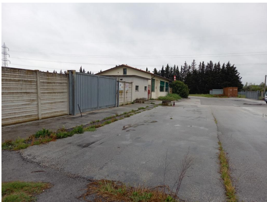
Foto 2 – panoramica del fronte sud sul parcheggio esistente. La pavimentazione in primo piano verrà mantenuta anche per le fasi successive in quanto al di sotto si essa sono presenti manufatti di scolo meteorico che si intende mantenere in funzione anche nel successivo utilizzo come impianto FV a terra dell’area.
