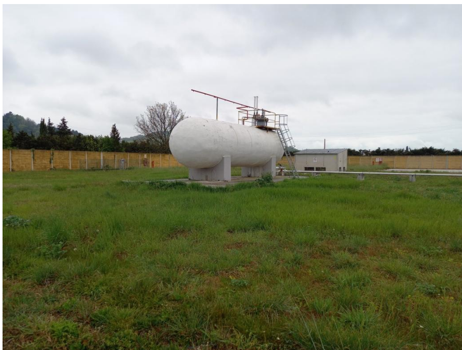
Foto 10 – bombola stoccaggio GPL. Per essa è prevista la vendita ad impresa che provvederà al recupero per riutilizzo.
