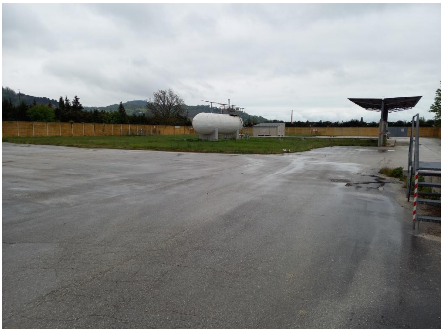
Foto 5 – La pavimentazione in asfalto in primo piano sarà rimossa e destinata a recupero con codice CER 170302.
