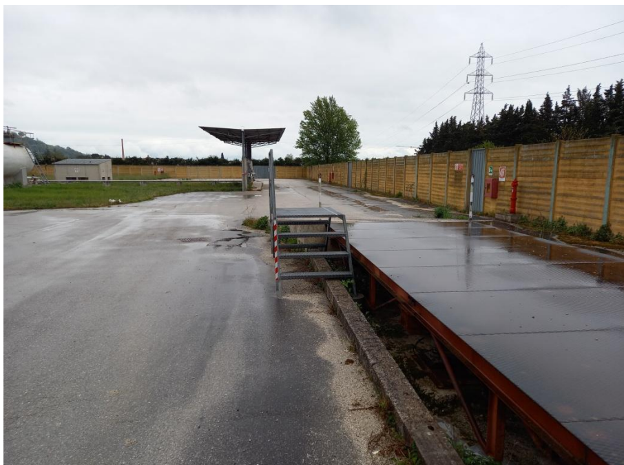
Foto 3 – in primo piano la pesa (già rimossa e rivenduta). Sullo sfondo la pensilina della zona di carico. I muretti in cls saranno demoliti, le tubazioni in ferro interrate saranno rimosse e destinate a recupero con CER 170405, così come ogni elemento in ferro e acciaio presenti nelle demolizioni stesse e che per motivazioni operative non possono essere destinati a riutilizzo o riuso (ferri di armatura ad esempio) oppure non più utilizzabile per effetto di mancato rispetto della normativa specifica vigente (ad esempio bocchette idranti, tubazioni, ecc.).
