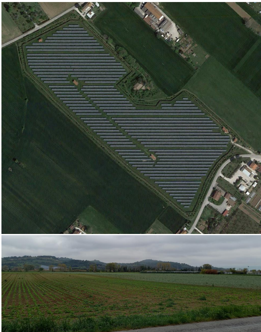
Foto 17 – impianto n.3 “Falcineto 2”. Impianto FV a terra di potenza stimata circa 4 MWp. L’impianto è dotato di una cortina vegetazionale esterna ben strutturata che ne limita la visibilità dalla via Falcineto. Le finiture di cabine ed installazioni realizzano inoltre una perfetta integrazione nel contesto paesaggistico locale. La foto inferiore mostra la visuale dalla via Falcineto in prossimità del margine NO dell’impianto e in direzione del sito di intervento di progetto. Sulla destra nella foto l’impianto “Falcineto 1” e sullo sfondo a sinistra nella foto l’impianto “Carrara” che essendo posto lungo il versante risulta ben visibile anche dalla via Falcineto. Non risulta invece visibile il sito di intervento.
