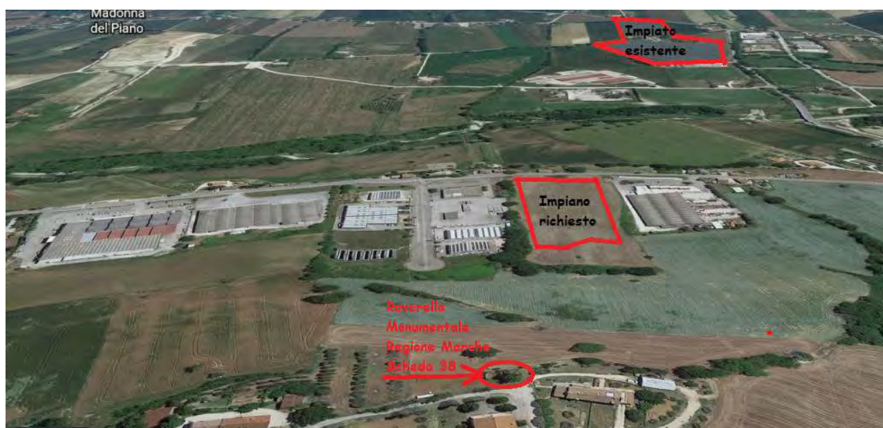
Fig. 4 La Roverella monumentale (scheda n.38) in posizione panoramica, sulla collina prospiciente il lotto individuato per l'impianto FV a terra, con l'impianto già esistente in territorio del Comune di Corinaldo in evidenza, vista la distanza esigua di 763 metri.
