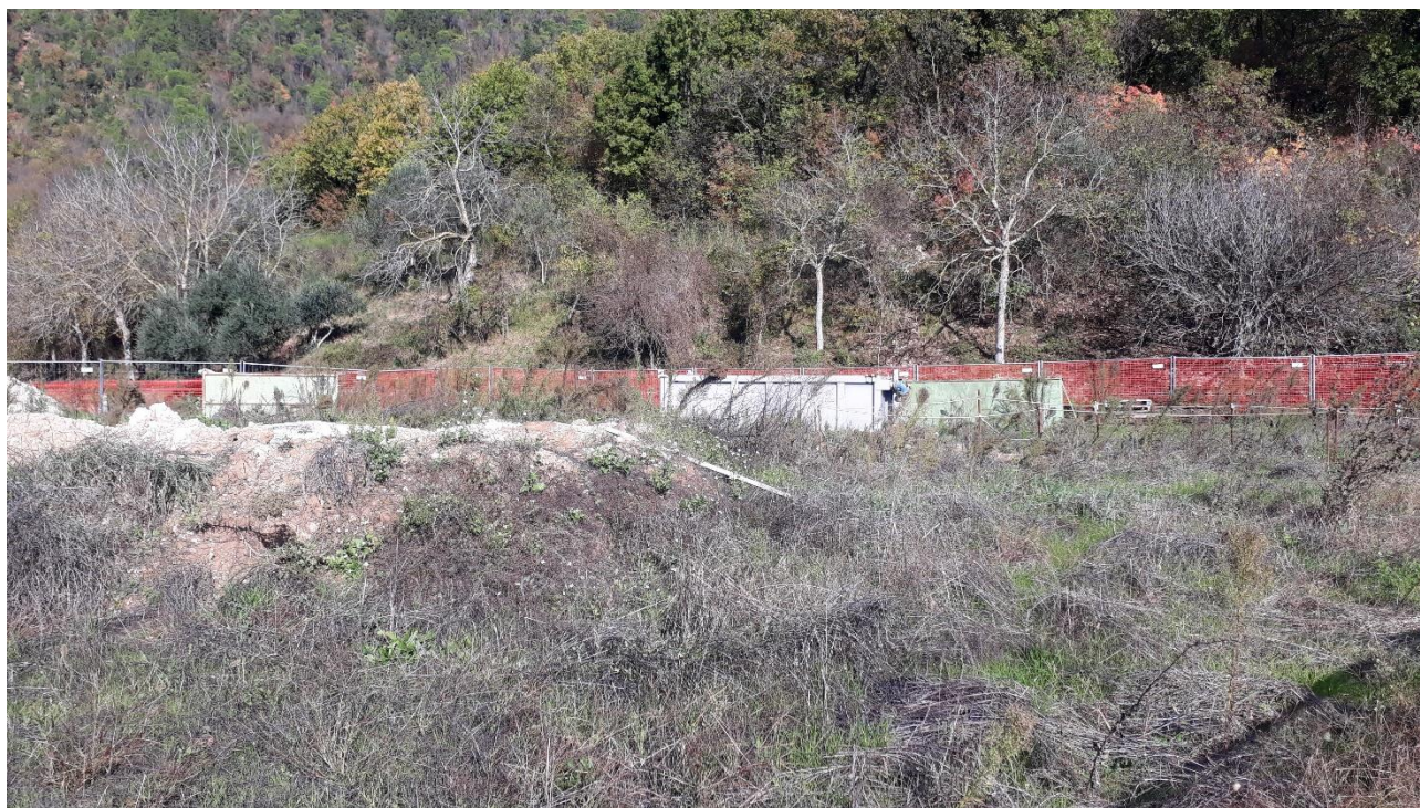
Figura 15: vasche di raccolta predisposte all'interno dell'area di cantiere
