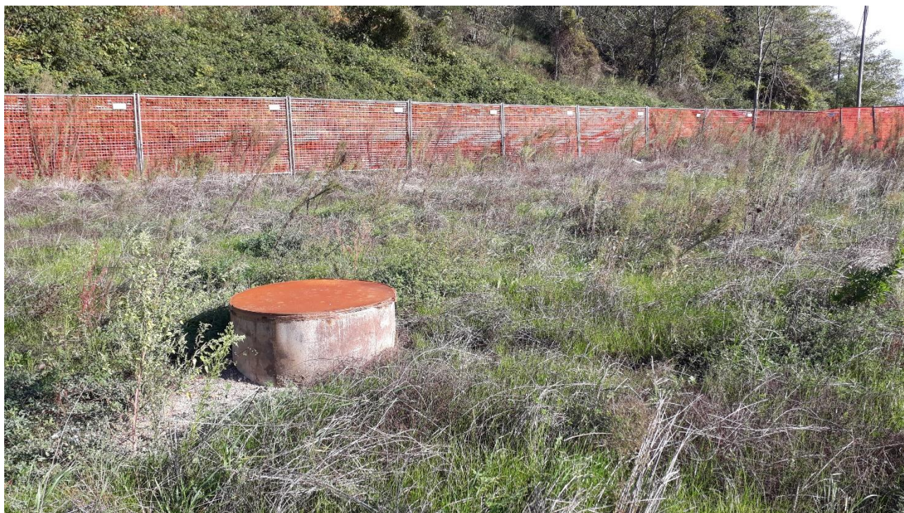
Figura 14: testa pozzo sigillata allo stato attuale
