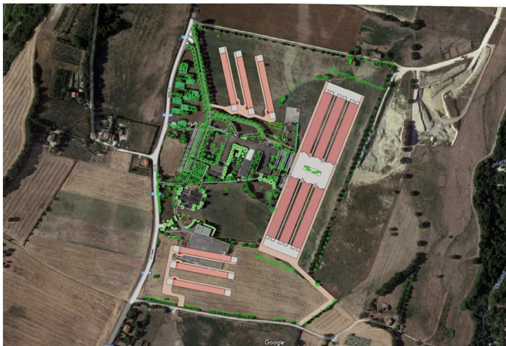
Foto n.3 - Aerofotogrammetria dell'area con presenza dei box di progetto
