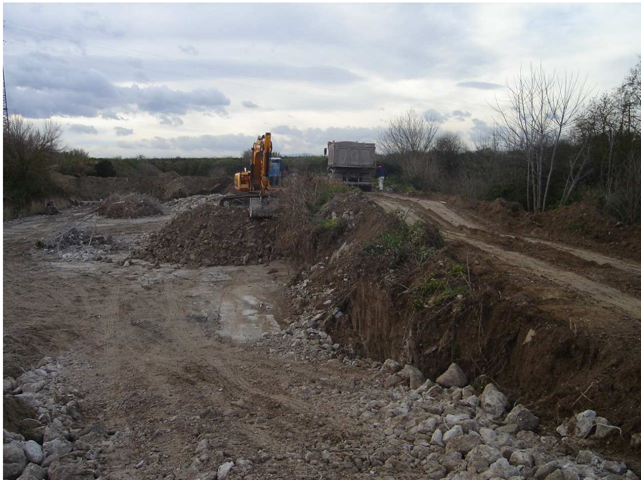
Foto10.5/6 Lavori di demolizione dei manufatti cementizi di una vasca
