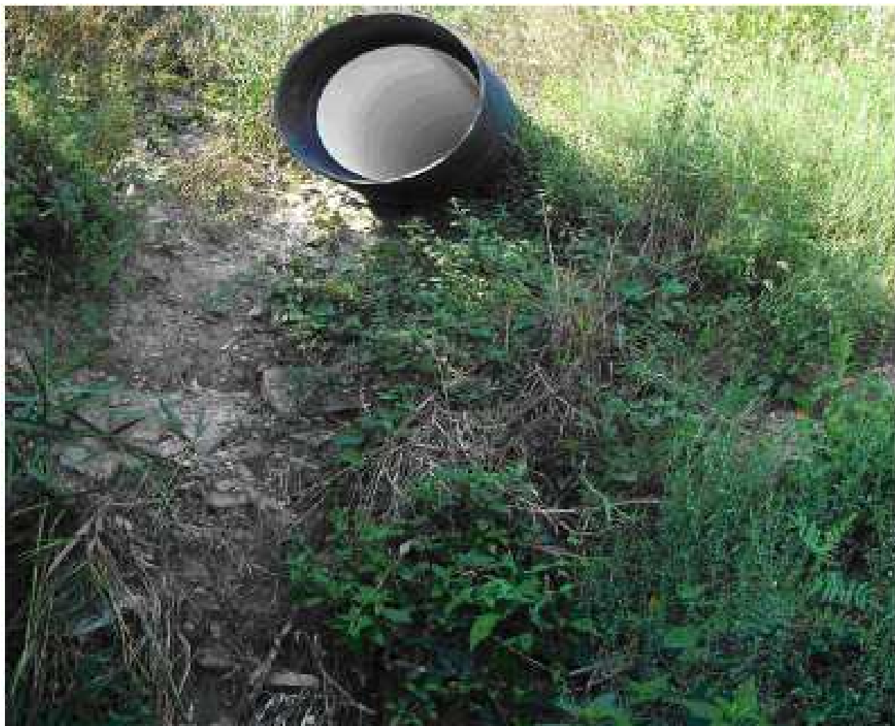
Foto10.5/1. Tubazione di alimentazione acqua di seconda pioggia allo stagno
