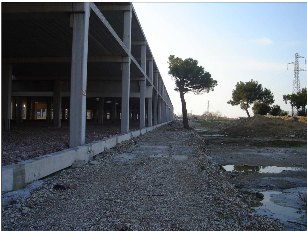
Foto 5.4/6 - Pini marittimi rimasti indenni in aree adiacenti i fabbricati industriali.
