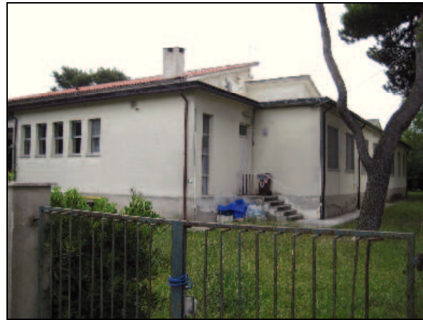
Fig. A2 - Scuola elementare Via Della Pineta
