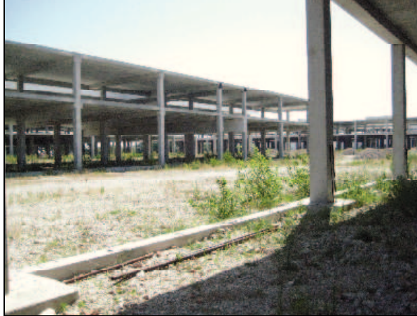
Fig. A4 - stato attuale all'interno del cantiere
