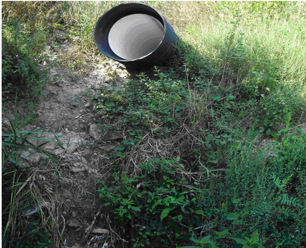
**Foto1. Tubazione di alimentazione acqua di seconda pioggia allo stagno 1**
