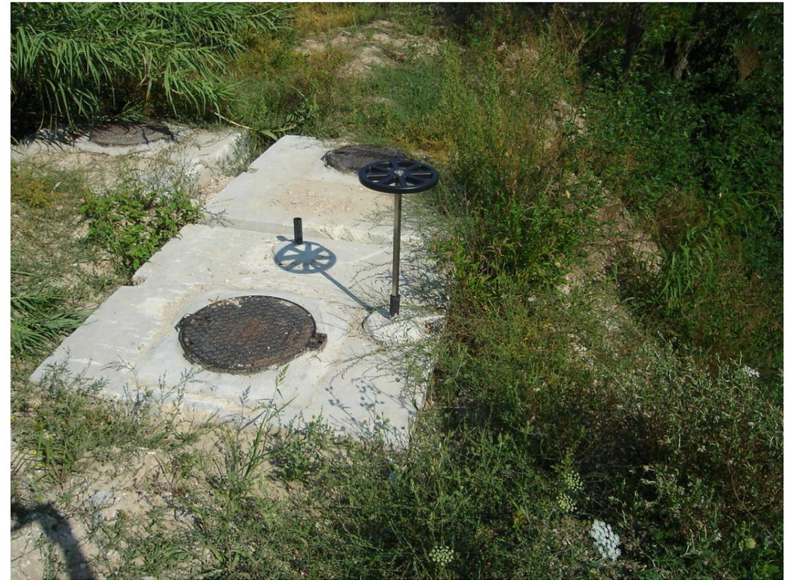
**Foto2. Valvola di regolazione del flusso di acqua dalla tubazione principale**
