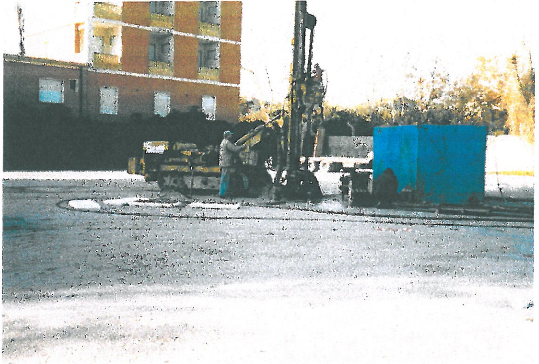
FOTO 13: Sondaggio 4. Ubicazione del sondaggio.
