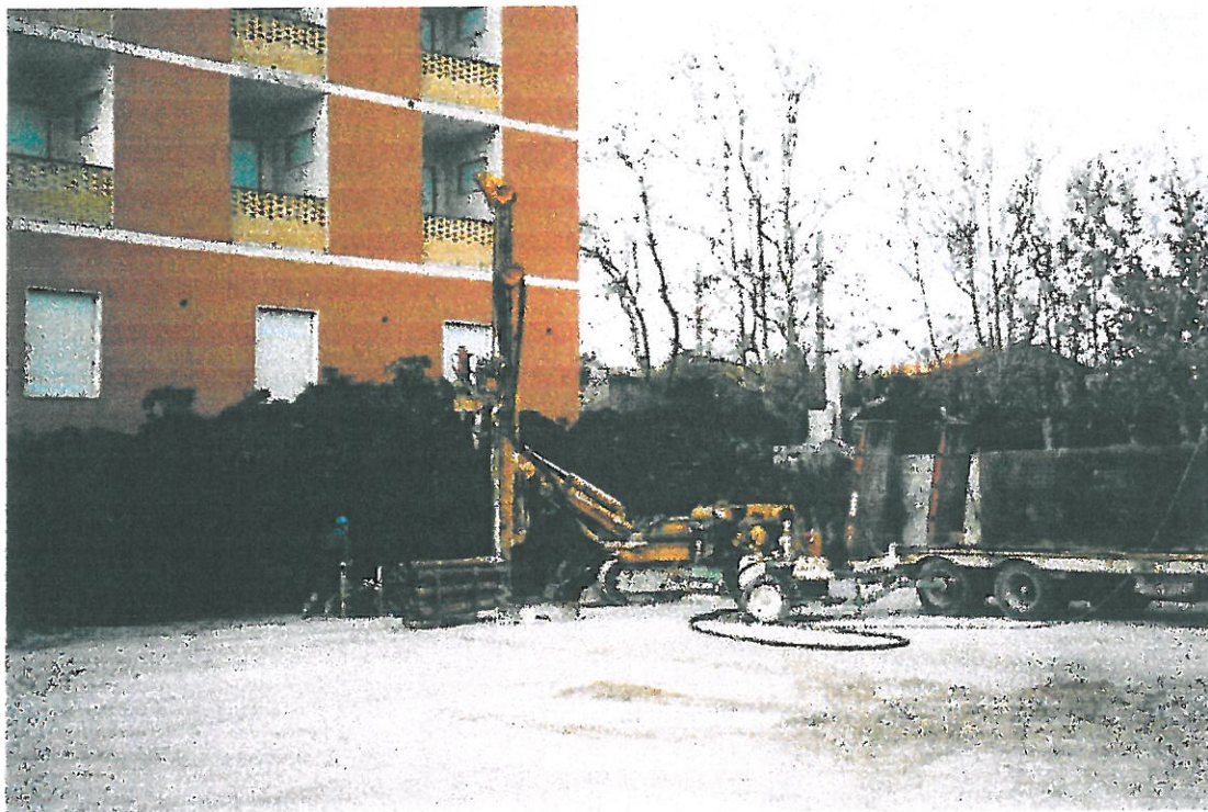
FOTO 1: Sondaggio 1. Ubicazione del sondaggio.
