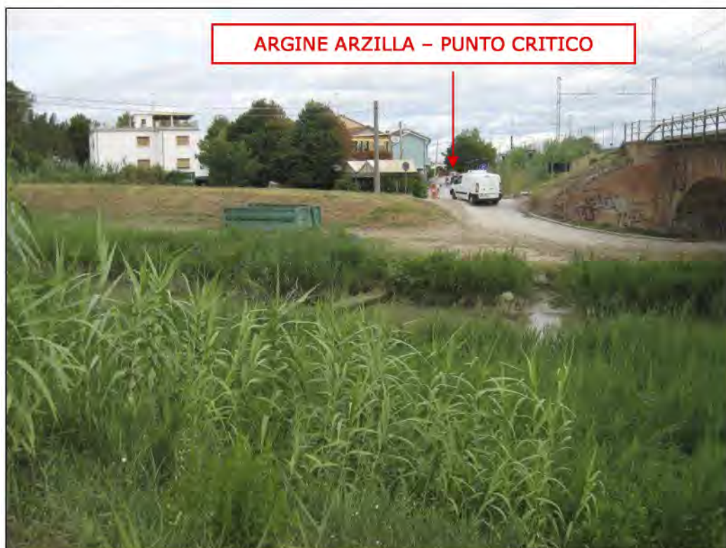
Fig. 8.1.a - Torrente Arzilla - argine sinistro a ridosso del ponte FF.SS.
