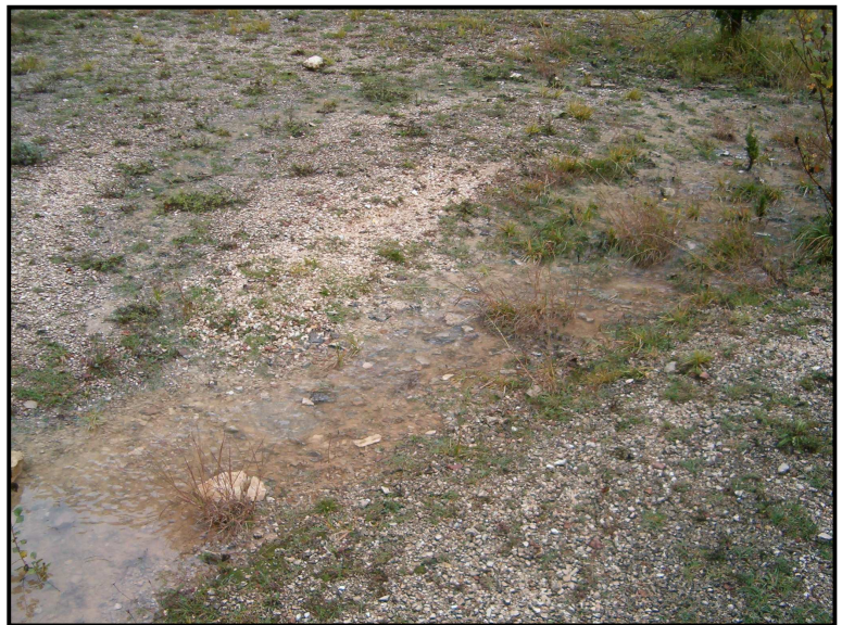
Durante i periodi piovosi o in episodi meteorici brevi ma particolarmente intensi, sui piazzali di cava si creano solchi di ruscellamento concentrato a forte potere erosivo.
