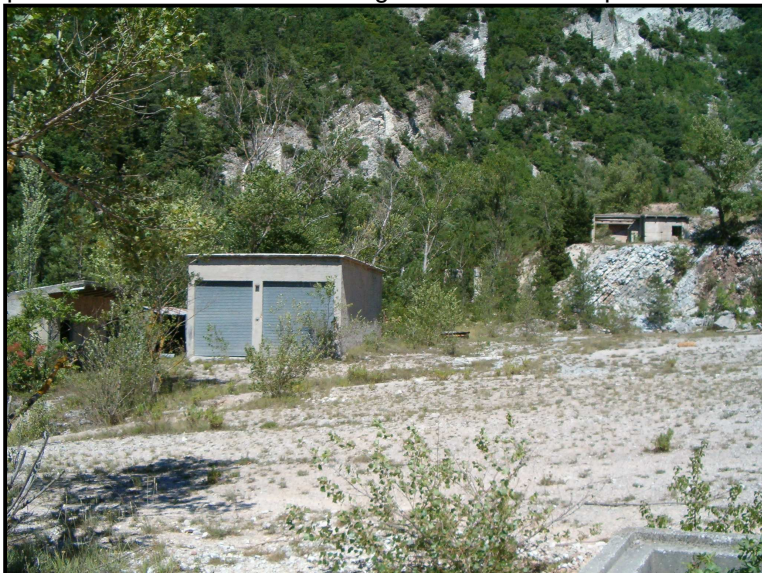
Le vecchie strutture di servizio alle attività di cava dovranno essere demolite; una sola fra queste verrà restaurata e adibita ad osservatorio – laboratorio.
