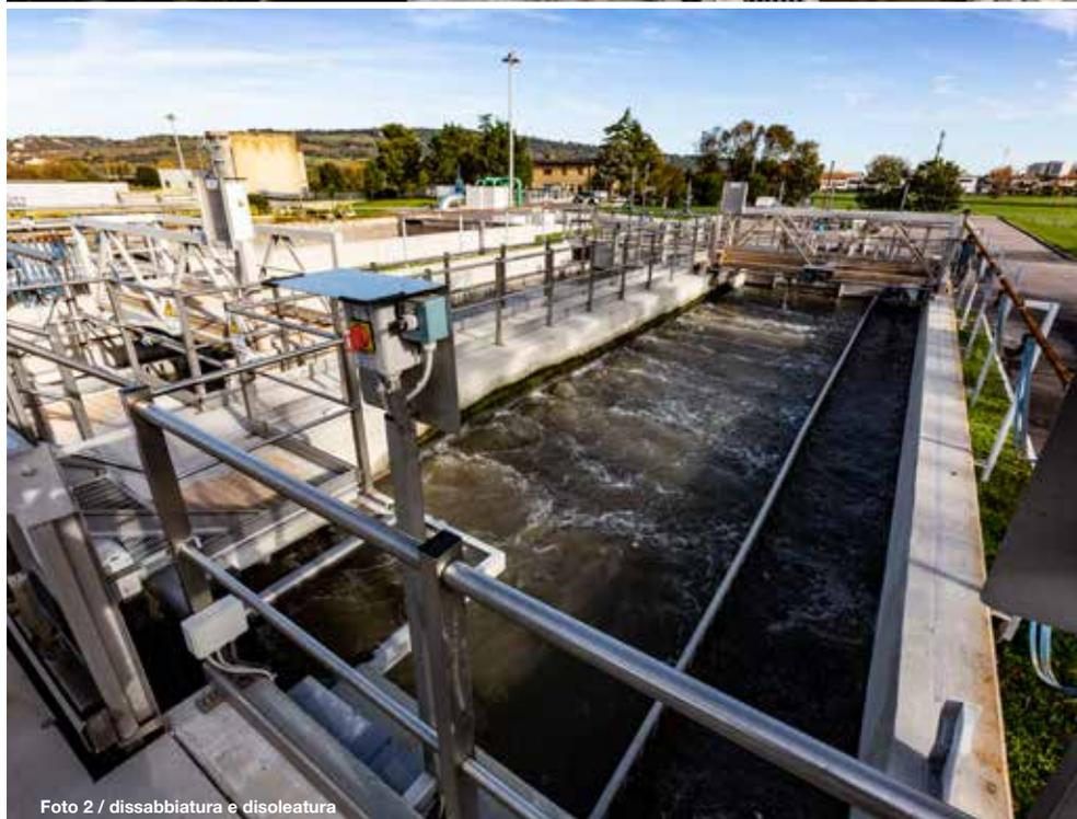
Foto 2 / dissabbiatura e disoleatura
