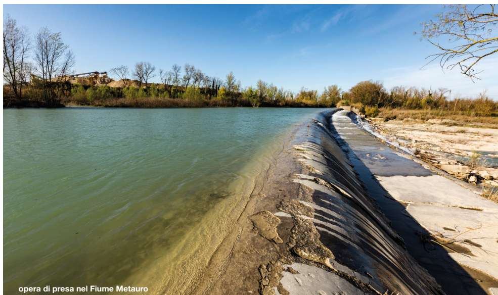
opera di presa nel Fiume Metauro
