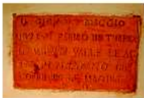
MATRINA A FIANDRO Mulino delle Scalas, Cagliari. Particolare della costruzione del bottaccio d'ago (1923).
