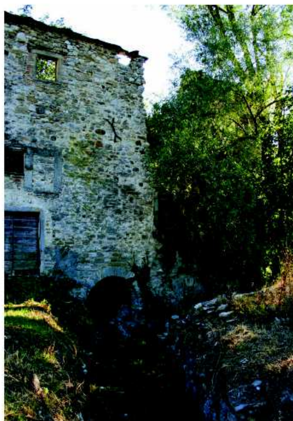
Mulino di Bascio, Pennabilli. Vano di scarico delle ritrecine.
