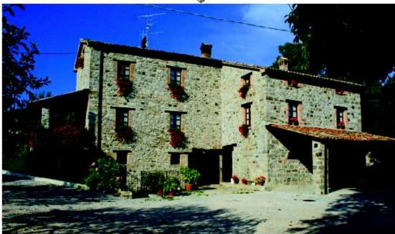
Sant'Agata Feltria, Rocca Pratiffi, via Fiume, 42 bis, Fossa della Rocca, Marecchia. Residenziale. Stato di conservazione: buono.
