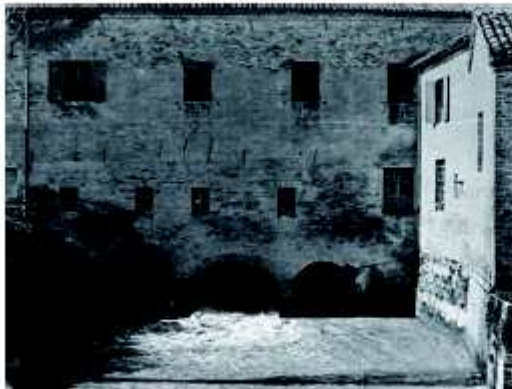
Milano Caronici, Pesaro. Vista dei muri di scario dell'edificio ancora in funzione.
