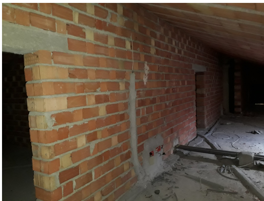
Figura 38 – Piano sottotetto – Corpo B – Muro di spina centrale
