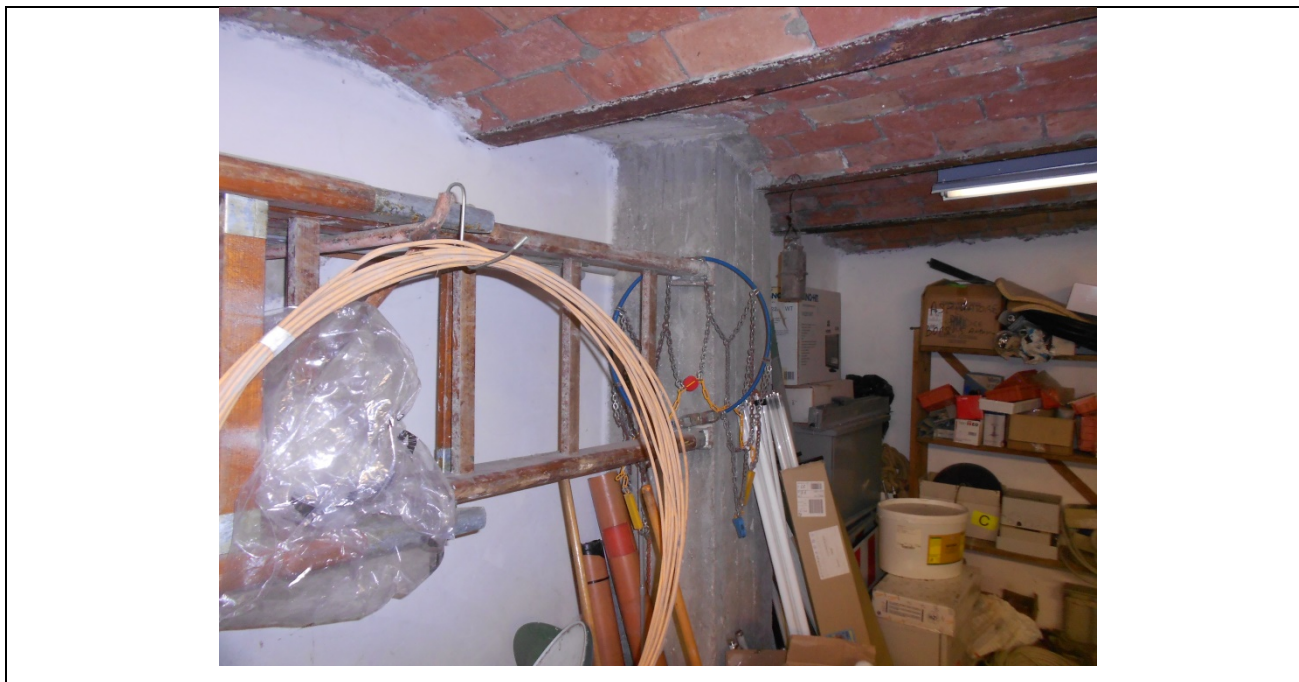
Figura 52 – Zona di interazione strutturale tra i corpi di fabbrica A e B
