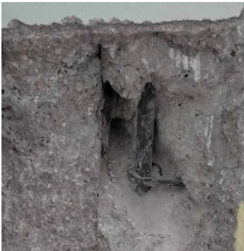
Figura 59 – Particolare staffa + ferro verticale
