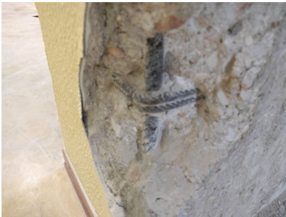
Figura 62 – Particolare raddoppio staffe estremi colonne
