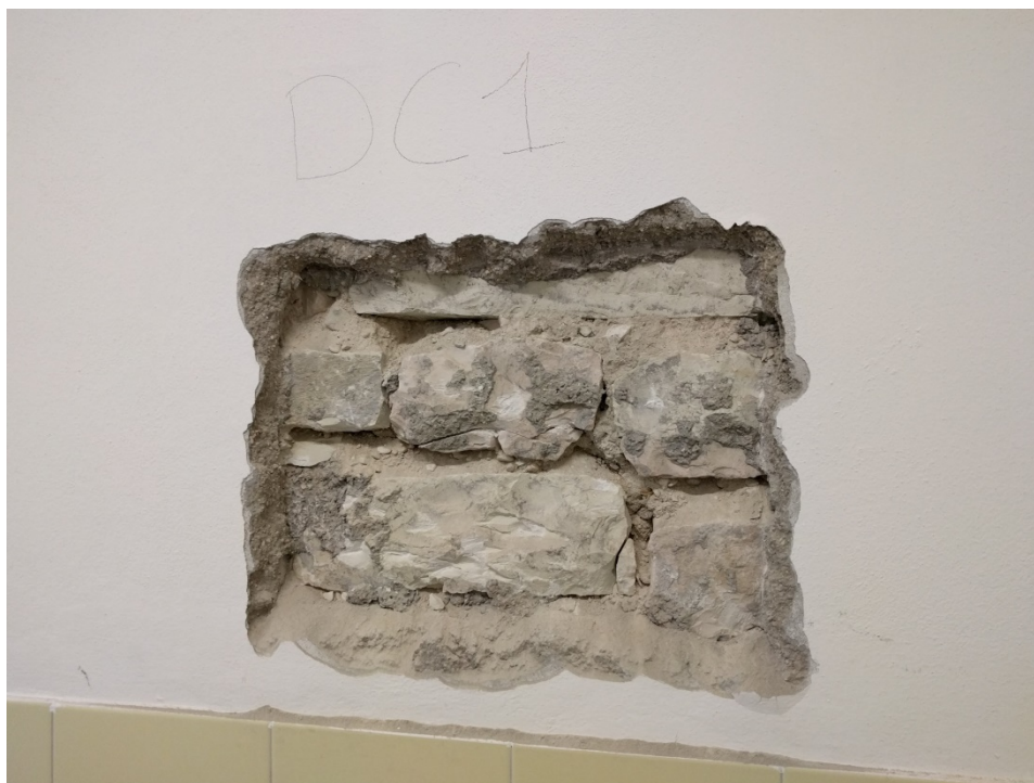
Figura 37 – Saggio piano rialzato – Corpo B – Muro di spina centrale
