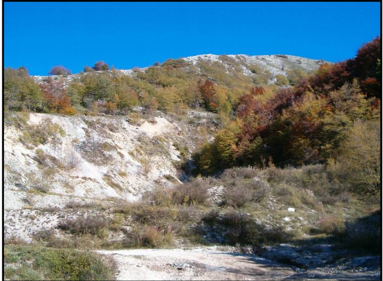
*Fig. 80 – Le ipotesi progettuali per la cava di Col Lungo prevedono il riporto di materiale inerte alla base dei fronti, per diminuire le pendenze e favorire la totale ripresa della vegetazione, anche con l'utilizzo di tecniche di ingegneria naturalistica.*
