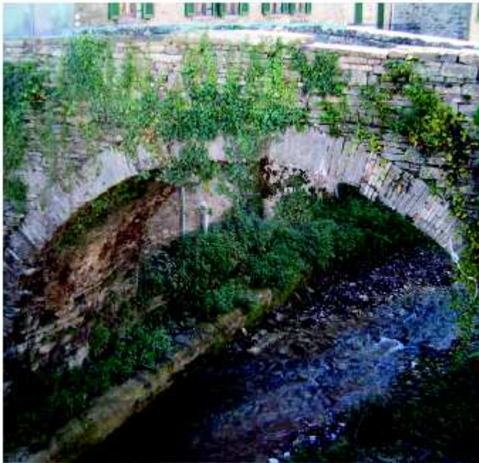
Il ponte in pietra di Lamdi.
